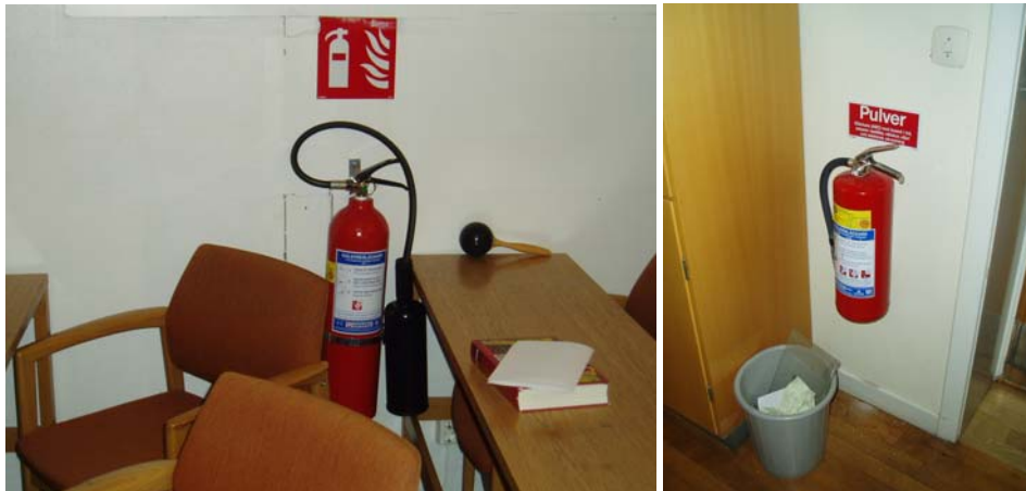
Figur 2.24 och 2.25 Exempel på handbrandsläckares placering.
