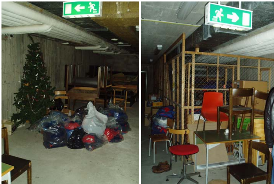
Figur 7.6 och 7.7 Förrådet under läktaren
