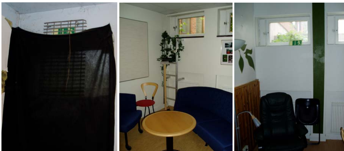
Figur 11.4 Exempel på bristfälliga fönsterutrymningsvägar. De är antingen svårtillgängliga eller dåligt markerade.
