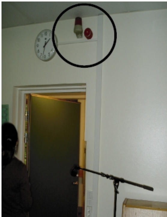
Figur 2.8 I musikrummen är utrymningslarmet förstärkt med en blixtljus.
