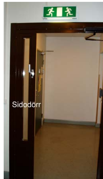
Figur 6.3 Utrymningsvägen mellan annexet och trapphuset.
