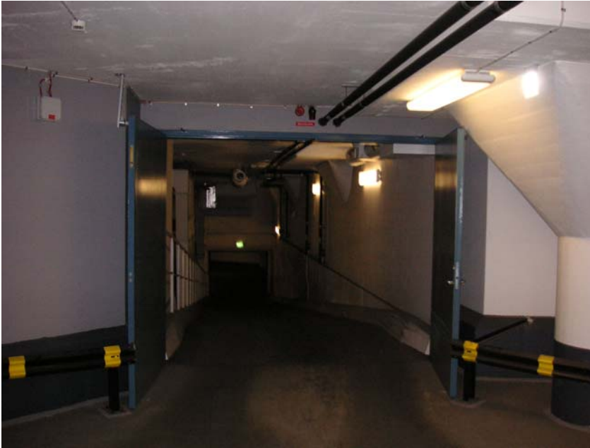
Figur 8. Dörrar till bilrampen som stängs automatiskt vid detektion i garaget.
