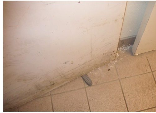
Figur 12-4 - Exempel på uppkilad dörr i brandcellsgräns.
