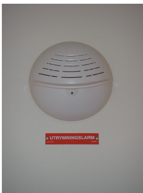
Bild 2. Larmdon för utrymningssignal med talad information.
