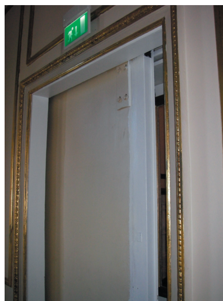
Bild 4. Glipa mellan dörrblad och karm.
