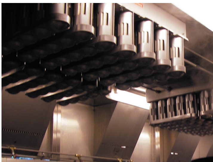
Bild 1. Punktskydd i kök över fritös och stekbord.
