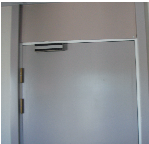
Bild 3. Dörr som saknar dörrstängare.
