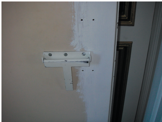
Bild 5. Utrymningsdörr i Franska matsalen.
