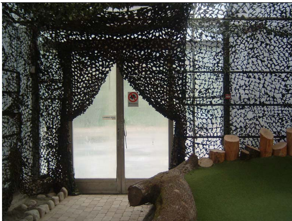
Figur 3.21 Delvis blockerad utrymningsväg i lokal 1
