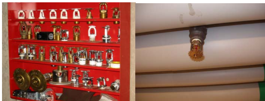
Figur 6. Sprinklertyper i sprinklercentralen samt installerat sprinklerhuvud.
