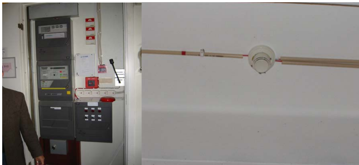
Figur 7. Brandförvarstablån samt rökdetektor.
