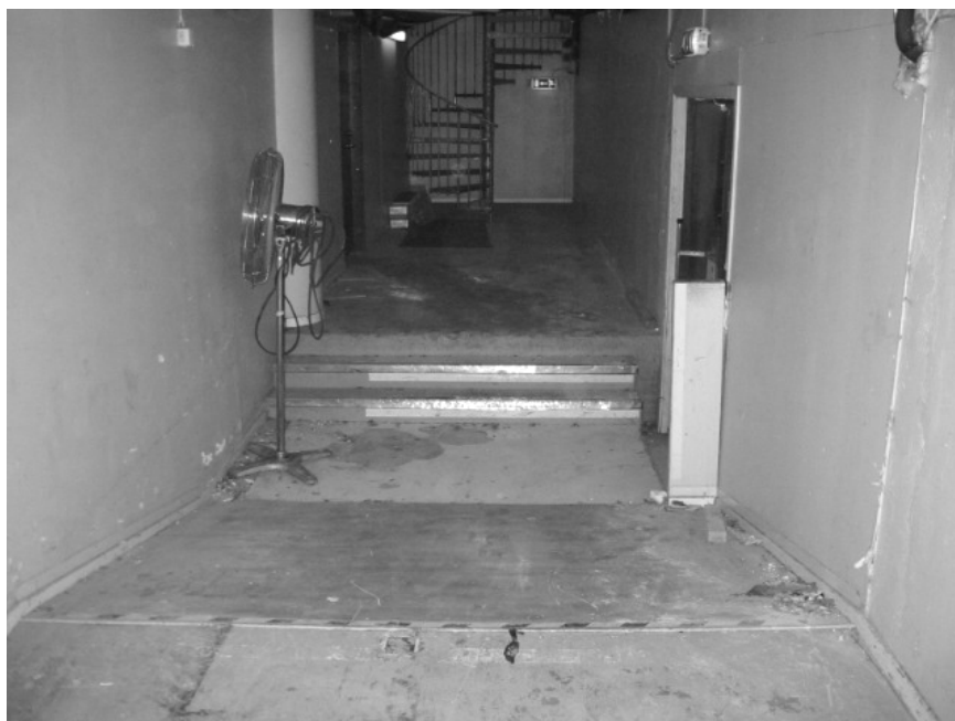
Bild 7.1 Ramp i utrymningsväg till garage
