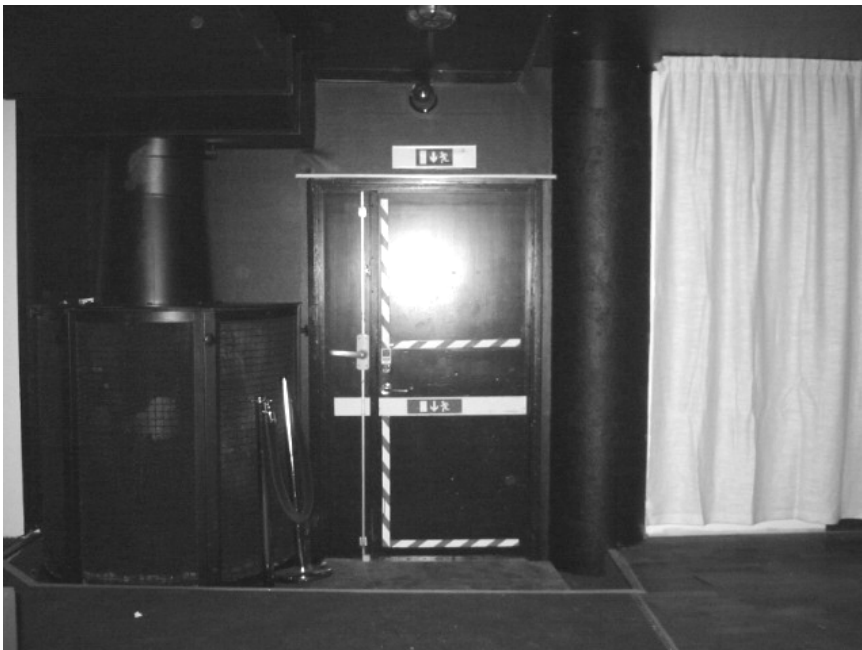
Bild 3.1 Utrymningsväg till garaget
