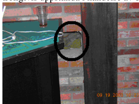
Bild 3.2 Hål i brandmuren på andra våningsplan i personalutrymmet.
