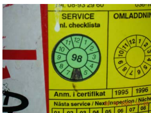
Bild 3.1 Exempel på undermålig kontroll av handbrandsläckare.
