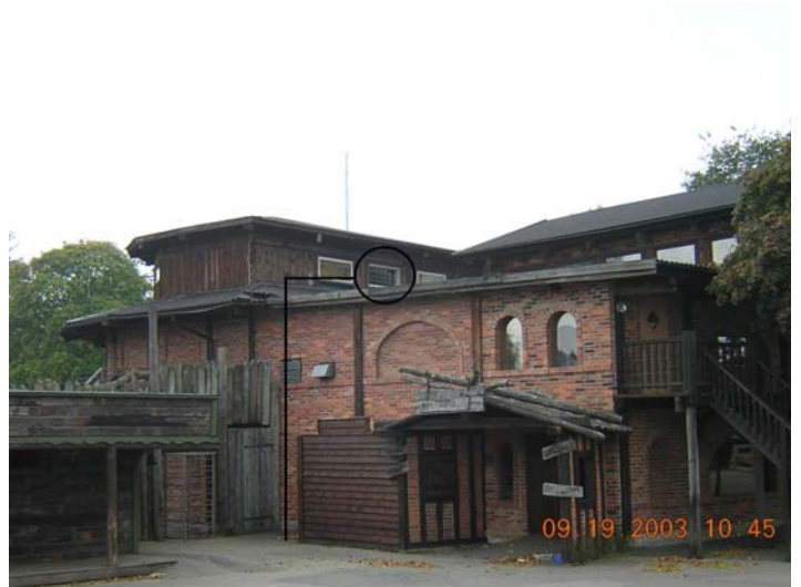
Bild 12.3 Här visas placering för ny nödutgång från våning tre. Denna bör utföras med kortast möjliga sträckning på taket för att minska tiden ovan personalrum. Placering på baksidan är vald med hänsyn till byggnadens arkitektur.
