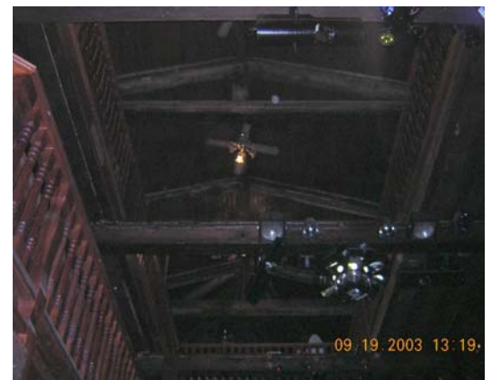
Bild 12.4 Takfläkten bör plockas ner vid montage av brandgasventilatorer.
