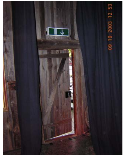
Bild 3.4 En icke belyst utrymningsskylt vid scenen.
