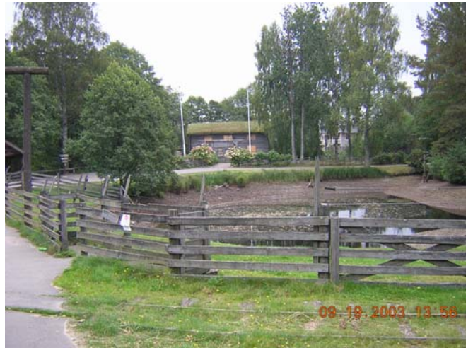
Bild 12.5 Vattennivå i branddamm
