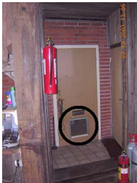
Bild 12.1 Dörr till pannrum
