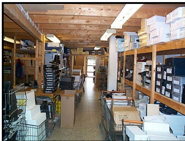
Figur 3.2. Blockerad utrymningsväg från skolagret.
