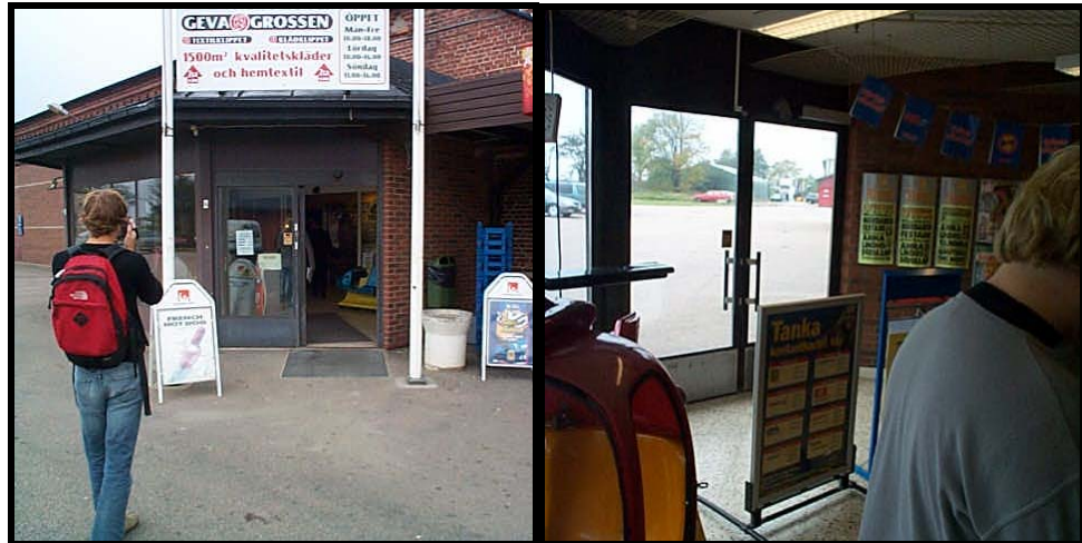
Figur 3.3. T.V. Huvudentrén utifrån. T.H. Den blockerade dörren i Huvudentrén.
