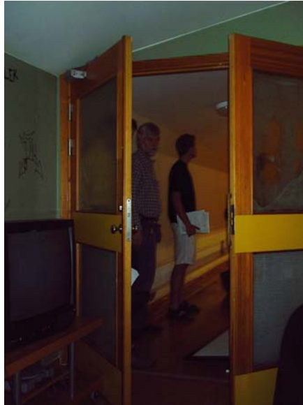
Bild VI. Blockerad Utrymningsväg från läktare
