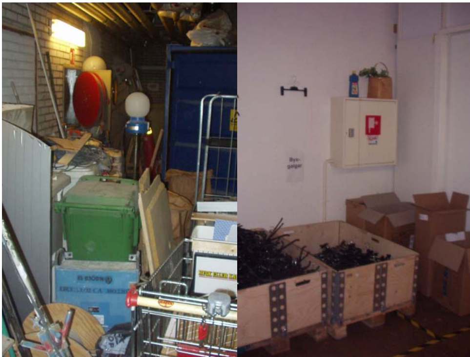
Bild 2.5: Blockerade brandredskap.
