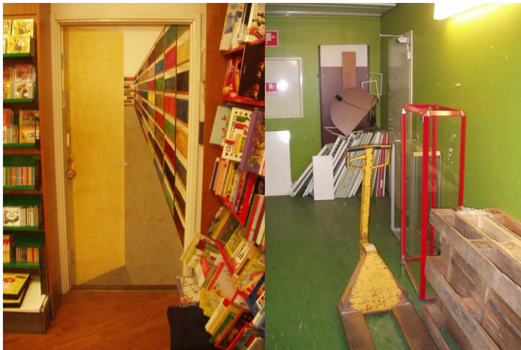
Bild 5.3: Förvirrande dörr i utrymningsväg samt blockerad utrymningsväg.
