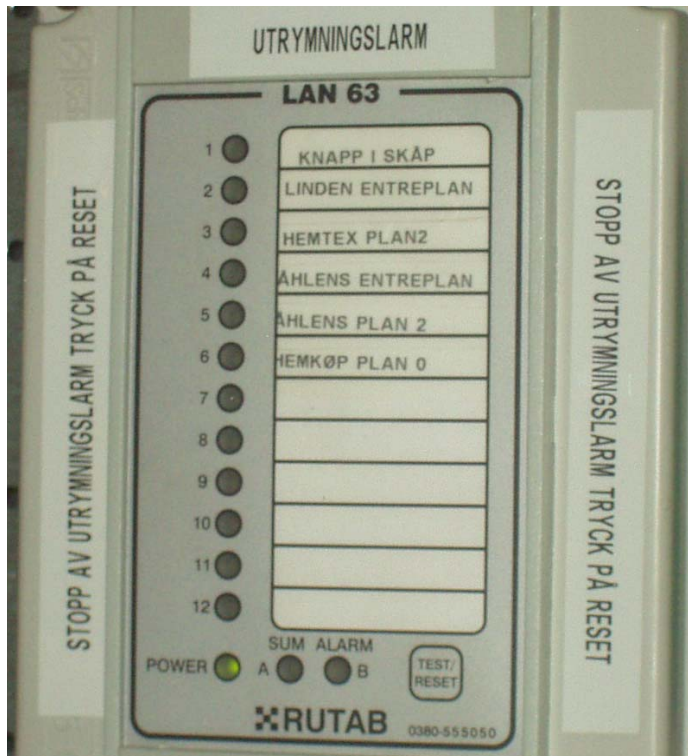
Bild 2.4: Aktivering av talat utrymningsmeddelande.
