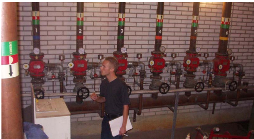
Bild 2.2: Sprinklercentralen.
