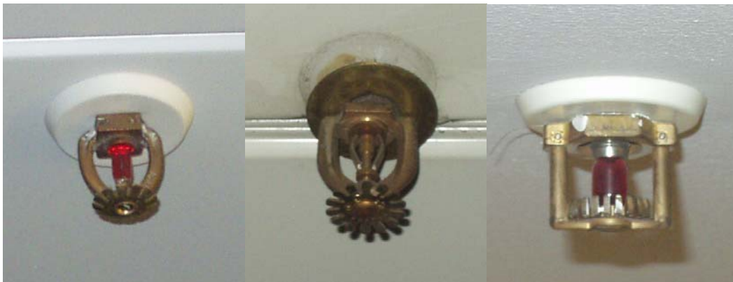
Bild 2.3: Tre olika sprinklermunstycken.
