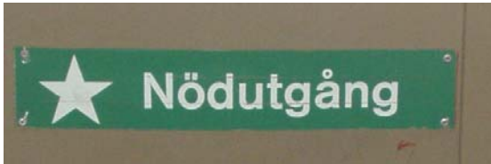
Bild 9.1: Äldre utformning av vägledande markering.
