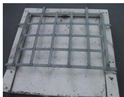
Bild 2: Röklucka, sedd från yttertak.
