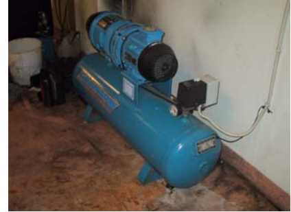
Bild 1: Kompressor i fläktrummet.
