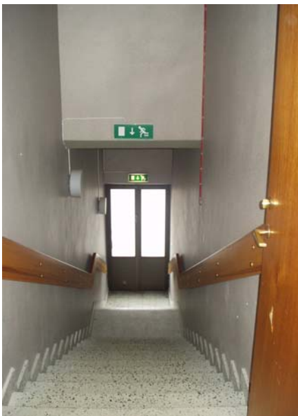
Bild 6.8: Främre nödutgång till Exit 1. via trappa 1
