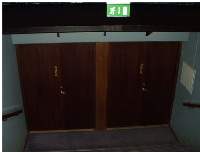
Bild 6.21: Publikingången/bakre nödutgång med trappa 3 till teaterfoajén.
