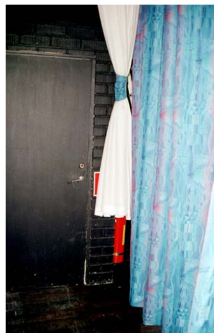
Bild 3.2: Dold släckutrustning i Trombon
