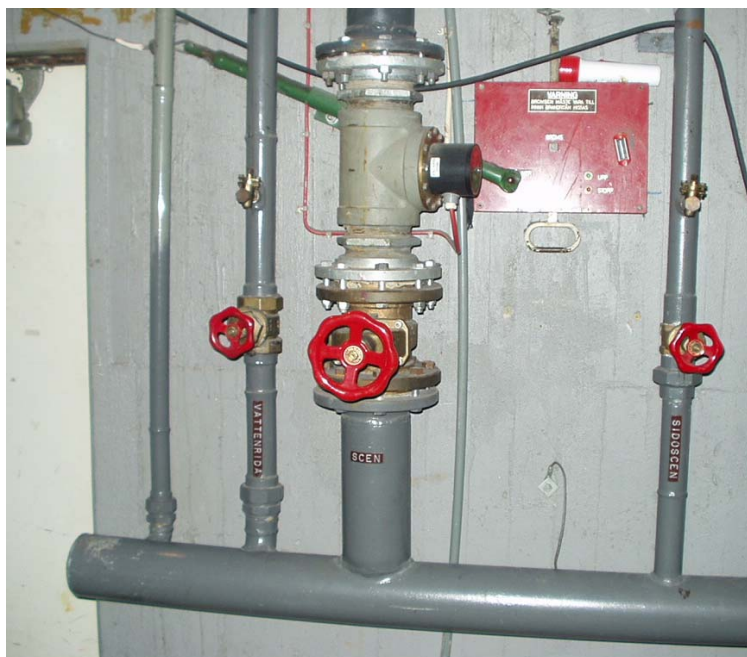
Bild 3.1: Sprinklercentral på sidoscen
