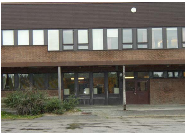
Bild 2.1: Söraskolans fasad mot sydost, sedd från återsamlingsplats
