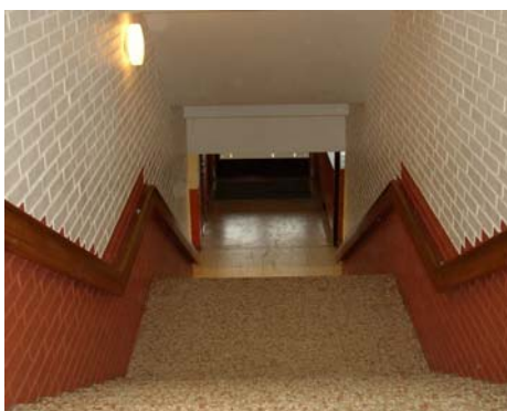
Bild 2.6 Trapphus med bredd 2,4 meter
