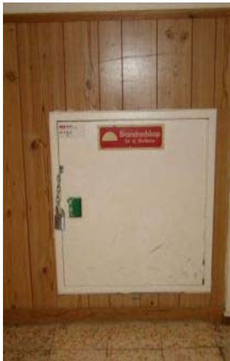
Bild 2.13: Brandpost med hänglås.
