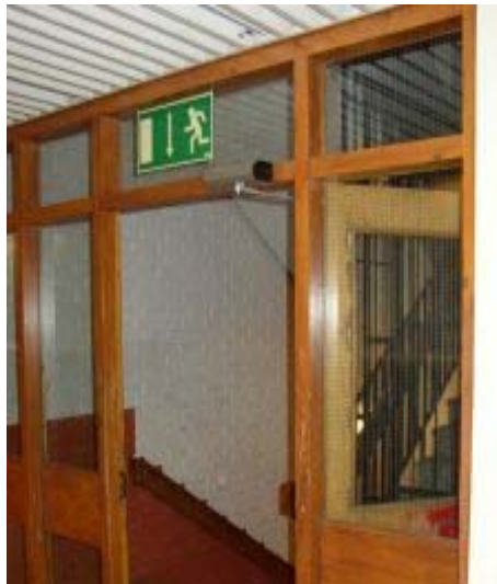
Bild 2.12: Magnetupphängd dörr för brandcell i trapphus
