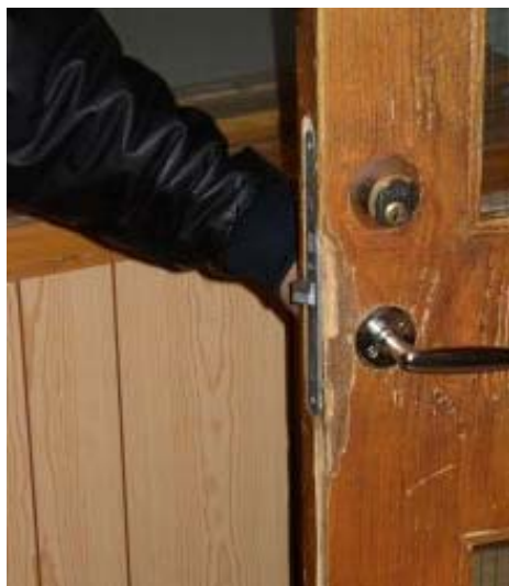
Bild 2.11: Brandcellbegränsande dörr med tvetsam röktätthet
