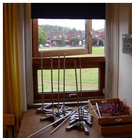
Bild 2.18: Fönster i NO-sal plan 1, ej lämplig för utrymning
