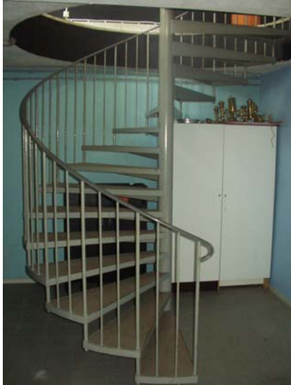
Figur 20. Spiraltrappa till nödutgång
