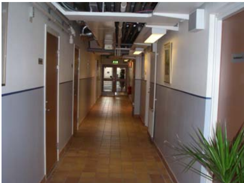
Bild 4. Korridoren på källarplanet.
