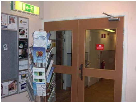
Bild 22. Blockerad utrymningsväg på källarplanet.
