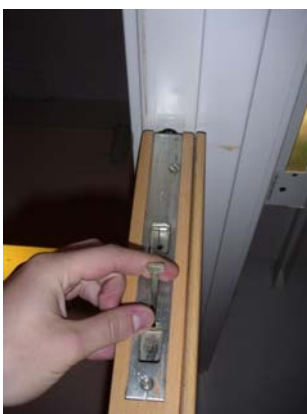
Bild 23. Öppningsanordning för utrymningsdörr på källarplanet.
