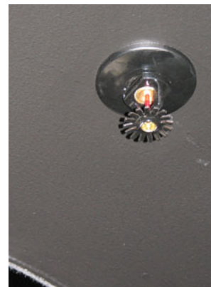
Figur 9.1. Extra insatt sprinklerhuvud.
