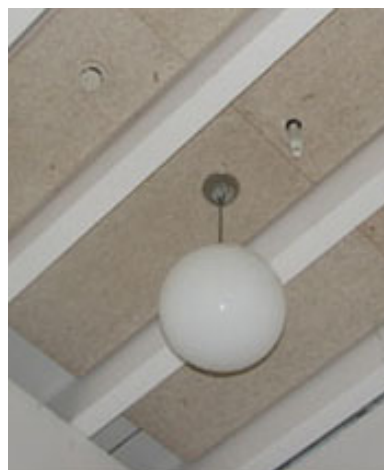
Figur 8.3. Placering av rökdetektor och sprinklerhuvud.
