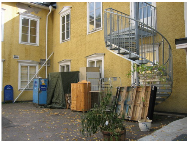
Figur 2.3. Delvis blockerad utrymningsväg från diskoteket.
