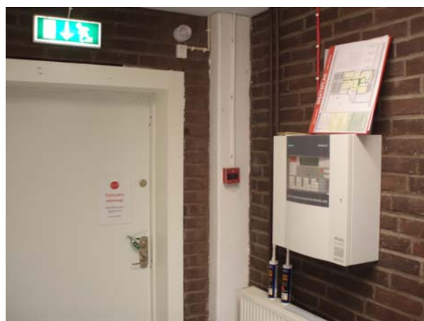
Figur 5.3. Bild på brandlarmscentral.
