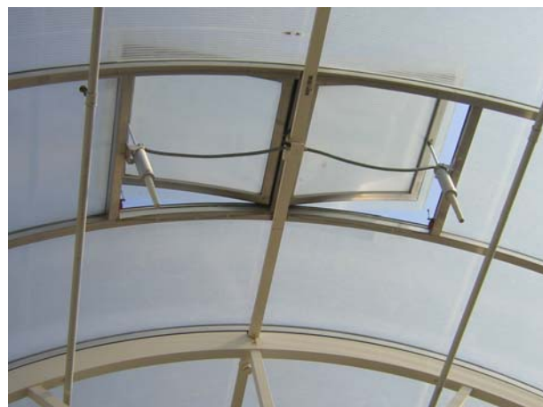
Figur 5.5. Rökluckorna i det högre partiet av Östra gången sitter parvis. Sammanlagt finns det sju par.
