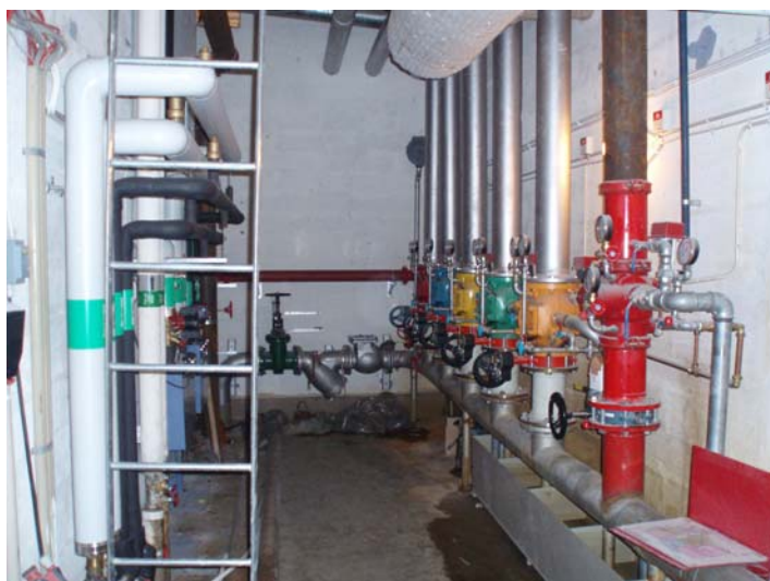
Figur 5.1. Bild på sprinklercentralen.
