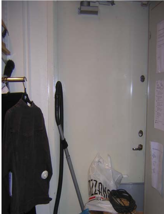
Figur X:1. Almias öppning till den brandtekniskt skilda utrymningsvägen är både låst och blockerad.
