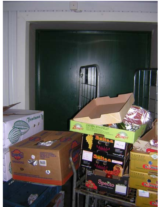
Figur X:2. En av Väsby Delikatessers öppningar till den brandtekniskt skilda utrymningsvägen.
