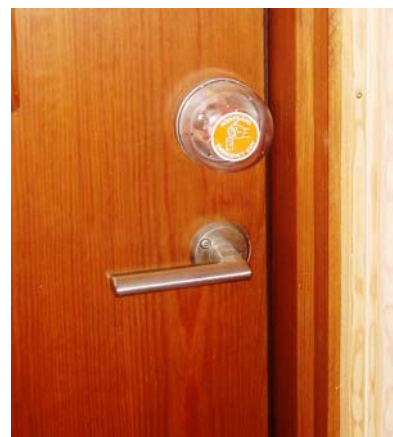
Figur 14. Låst dörr med kåpa över vredet
