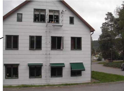
Figur 25. Utrymningssteg från vind.
