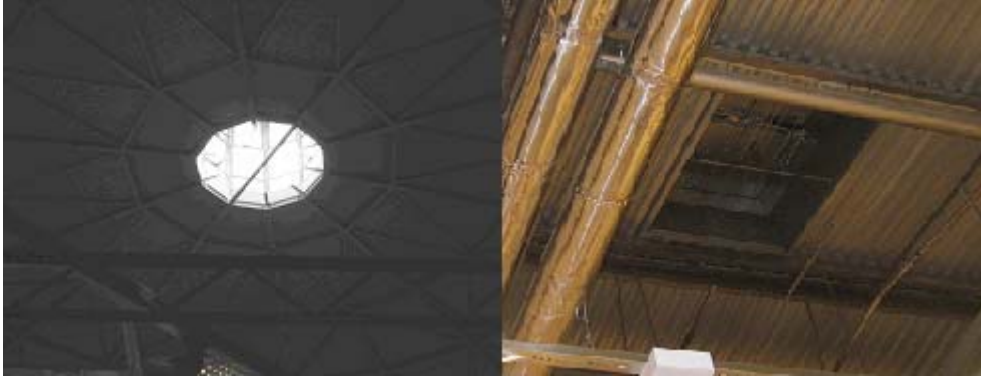
Figur 3.1 Brandgasluckor i ariet och gamla mässhallen
