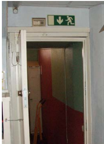
Bild 4.4 och 4.5. Bilder på genomlyst och självlysande utrymningsskylt. Foto: Jakob Dahlqvist 2006
