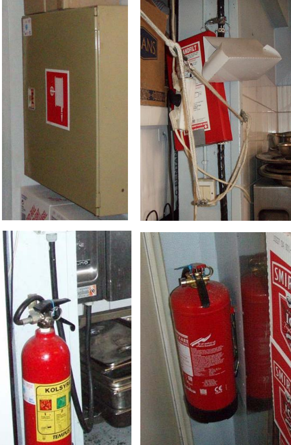
Bild 12.5-12.8. Kökets släckutrustning: Centrumrulle, brandfilt, koldioxid- och skumsläckare. Foto Jakob Dahlqvist 2006
