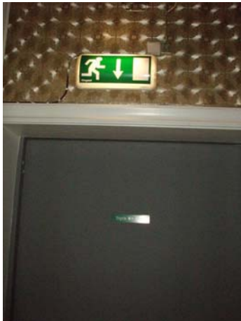
Bild 4.4 och 4.5. Bilder på genomlyst och självlysande utrymningsskylt. Foto: Jakob Dahlqvist 2006
