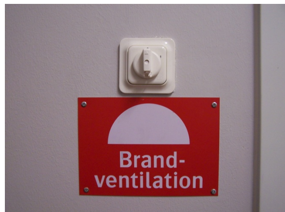
Figur 2.2 Brytare för brandgasventilation
