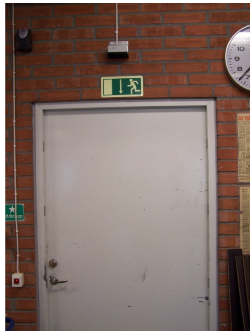
Figur 2.3 Utrymningsväg i verkstad
