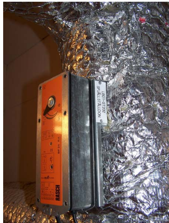
Figur 7.1 Motor till brandgasspjäll
