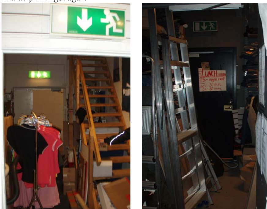
Figur 10.1 Exempel på begränsad framkomlighet i utrymningsvägar genom två olika butikers lager.
