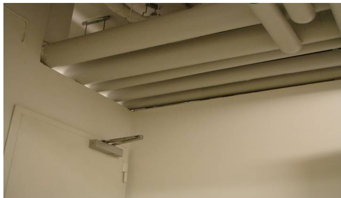
Figur 9.2 Genomföring mellan brandceller i källaren.
