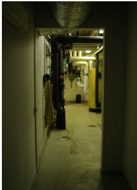
Figur 9.1 Nödutrymningsväg genom pumprummet.
