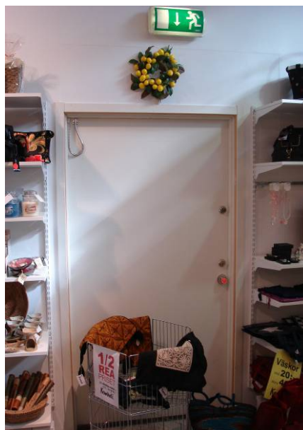
Figur 9.4 Blockerad nödutrymningsväg på Kembali.
