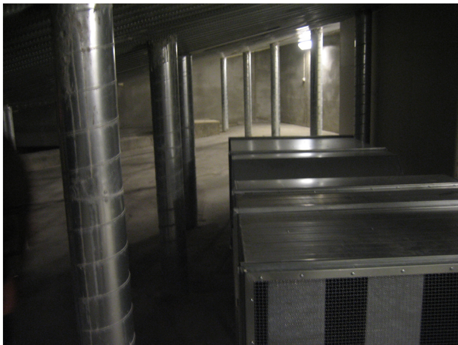
Bild 3.4 Tryckkammaren under kongresshallen.
