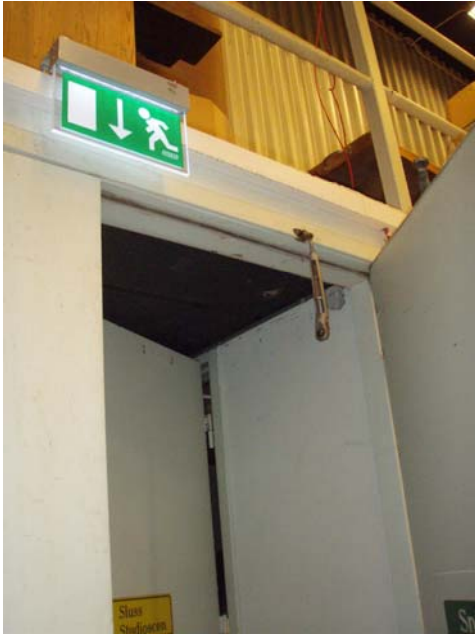
Figur I:7 Trasig dörrstängare
