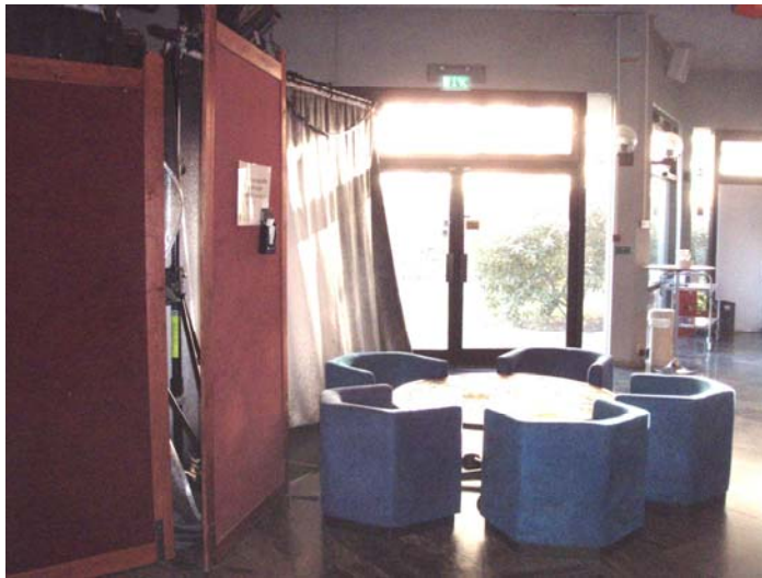
Figur I:4 Hinder framför nödutgång
