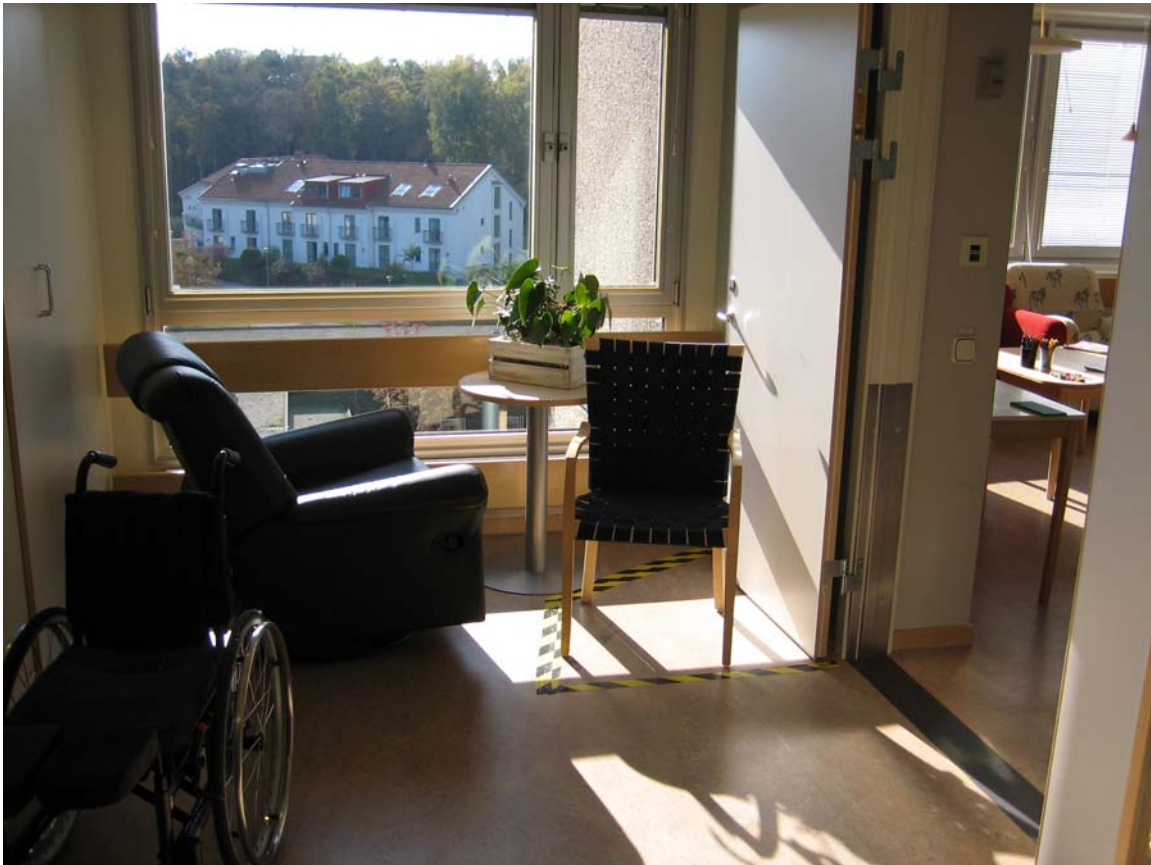
Figur 6. Magnetuppställd dörr blockerad av stol.
