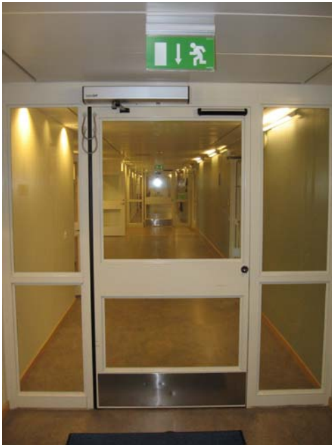
Figur 3. Dörr i primär utrymningsväg.
