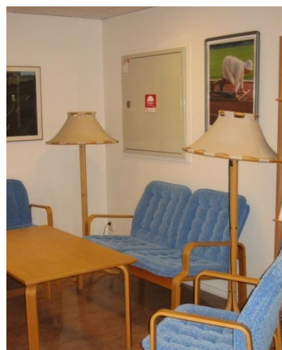
Figur 4.1 – Inomhusbrandpost blockerad av soffgrupp
