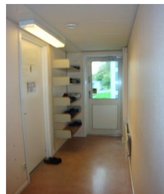
Figur 4.6 – Oskyltad utrymningsväg i motionslokalen
