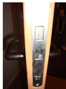
Figur 4.3 – Brandcellsavskiljande dörr med skruv insatt i stängmekanismen.
