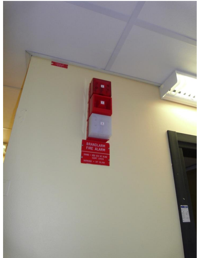
Bild 1. Larmstapeln på avdelning K83. Vid larm på egen avdelning ljuder larmet och det röda blixtljuset blinkar. Vid larm på närliggande avdelning blinkar endast det vita blixtljuset.
