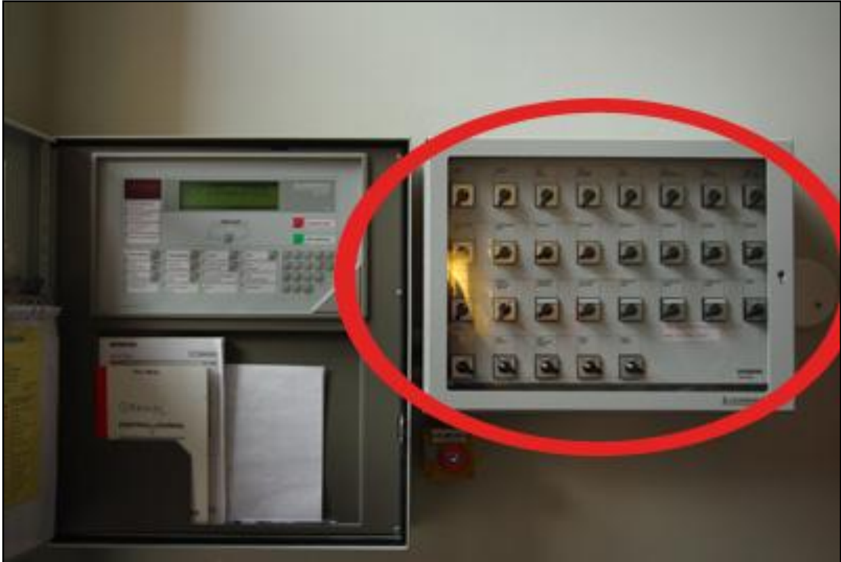
Figur 8. Manövrering för handkörning av till- och frånluftsfläktar vid brandförsvarstablån.
