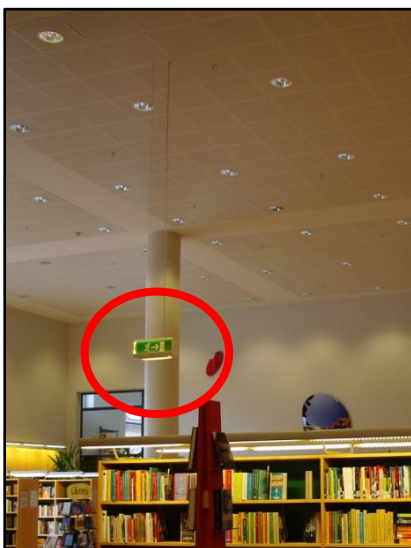
Figur 22. Exempel på utrymningsskylt som hänger från taket.
