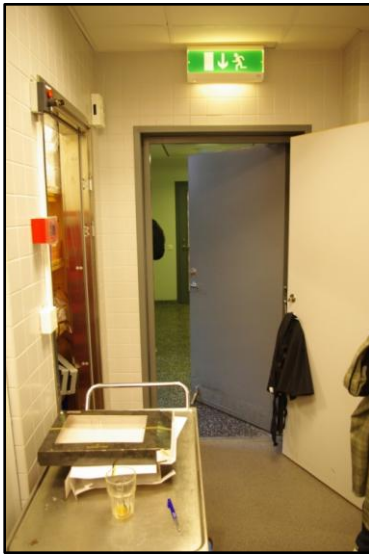
Figur 25. Uppställd dörr i brandcellsgräns mellan caféets kök och trapphus B.
