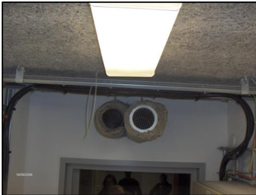
Figur 21. Ventilationskanal i brandcellsgräns som är helt öppen och ej försedd med brandgasspjäll.
