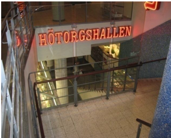
Figur 3.5 Väg till utrymningsväg från saluhallen via trappa B
