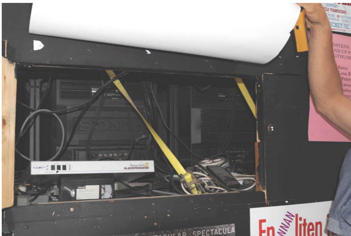
Figur 3.9: Bild utvisande insidan av tv-stapeln i Hantverksgången.
