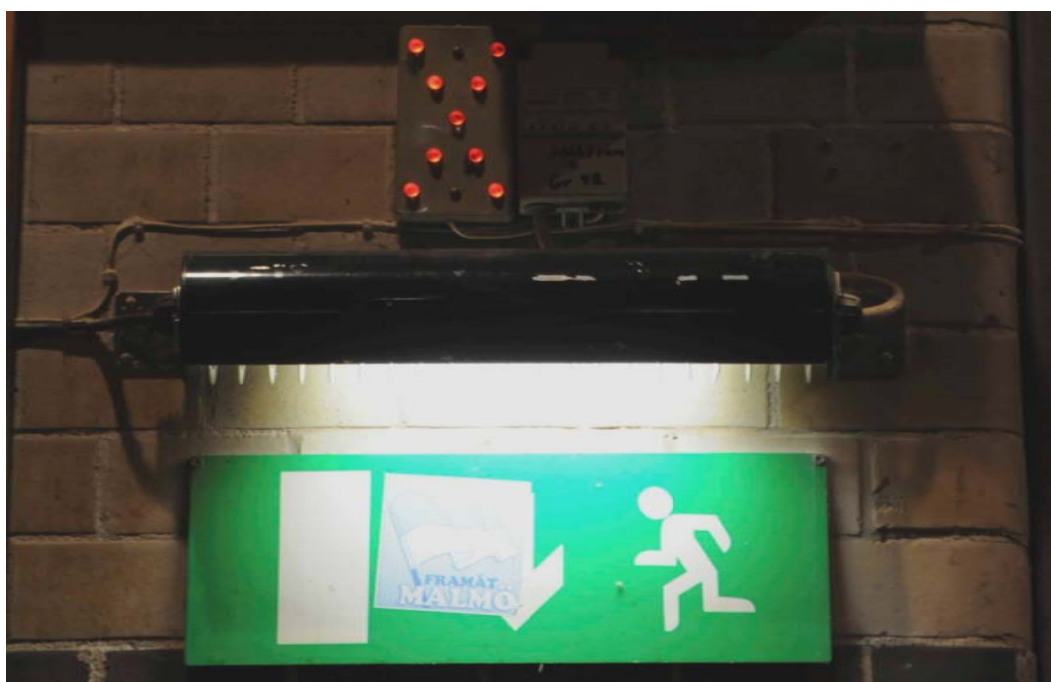
Figur 2.10: Ovanför utrymningsskylten finns ett diodkryss så att personalen kan veta om utrymningsdörren är låst eller olåst. Om dörren är låst lyser krysset med tydlig röd färg.
