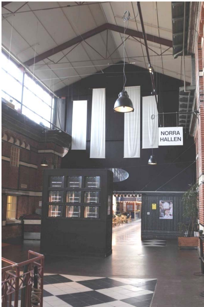
Figur 7.4: Bild tagen från Hantverksgången mot Bakgården. Bakom stapeln av tv-apparaterna syns det tygskynke som är uppspant hela vägen upp till taket. Tyget är flamskyddsbehandlat.
