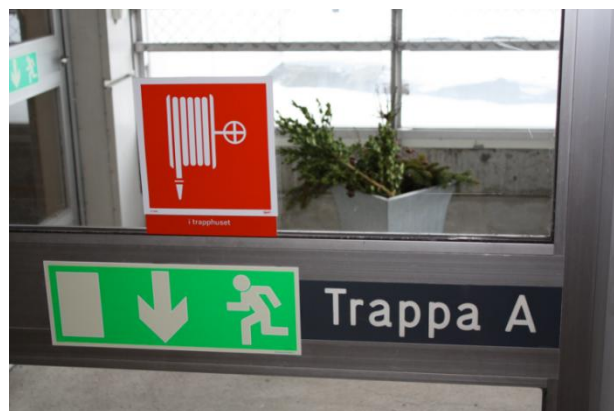
Figur 6. Dörr till utrymningsväg via Trappa A.
