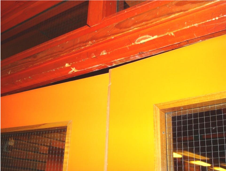
Figur 22. Visar dörrar i korridoren i sitt stängda läge. Brandgaserna sprids lätt genom springan. Dörrarna står i vanliga fall uppställda mot väggen med hjälp av magneter.
