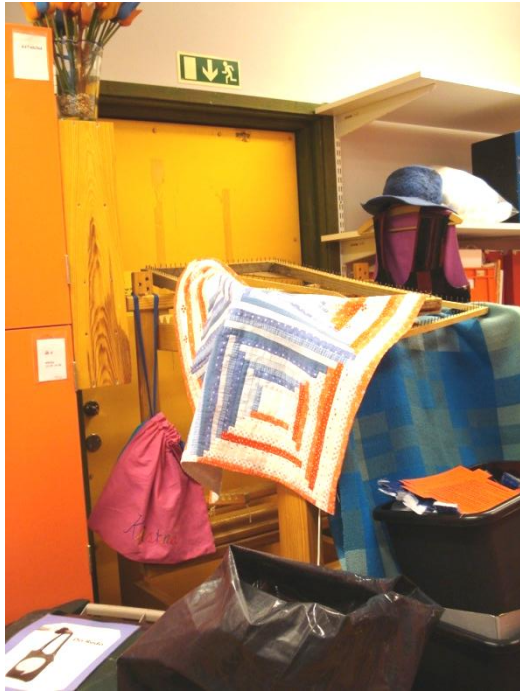
Figur 20. Visar en blockerad utrymningsväg i textilslöjden.
