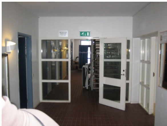
Figur 6: Korridoren i riktning mot trapphus 1.
