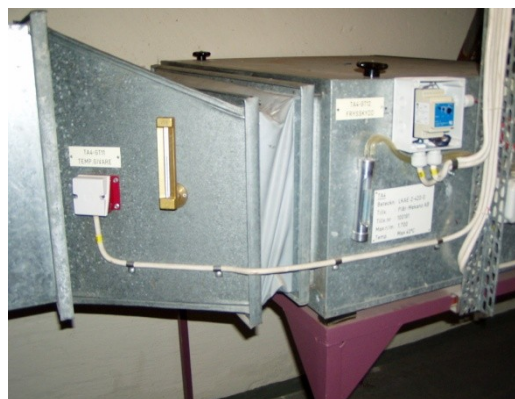
Figur 34: Närbild av ventilationsaggregatet.
