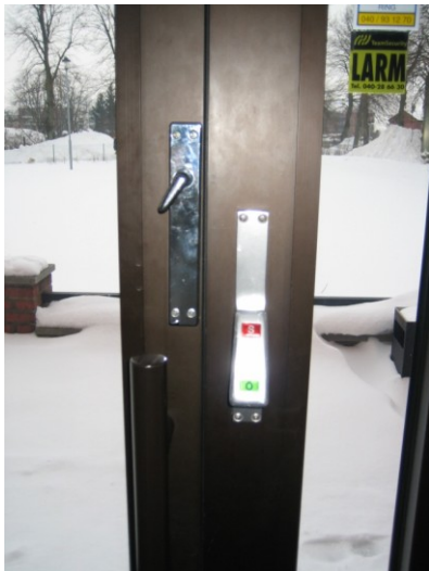
Figur 42: Dörrbeslag på utrymningsdörrar i södra delen av byggnaden.
