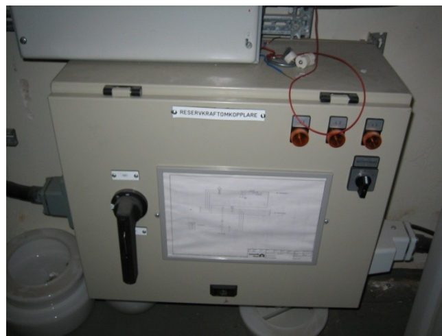
Figur 31: Reservkraftsomkopplare i elcentralen.
