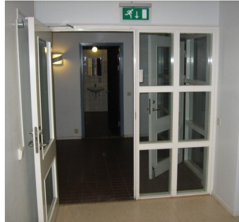
Figur 23: Den magnetuppställda dörren till foajén från trapphus 2.
