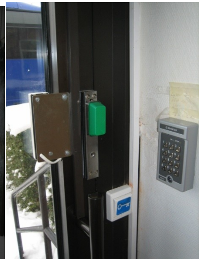
Figur 44: Utrymningsdörr i trapphus 2.
