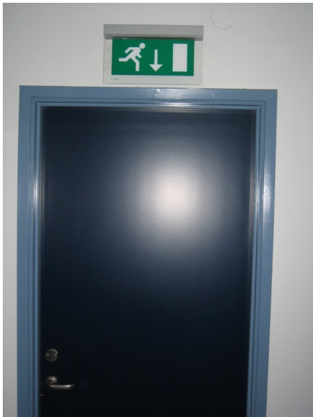
Figur 45: Utformning av den belysta utrymningsskylten som förekommer i större delen av byggnaden.
