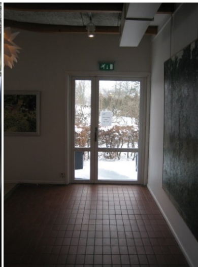
Figur 43: Utrymningsdörr i kaféet.
