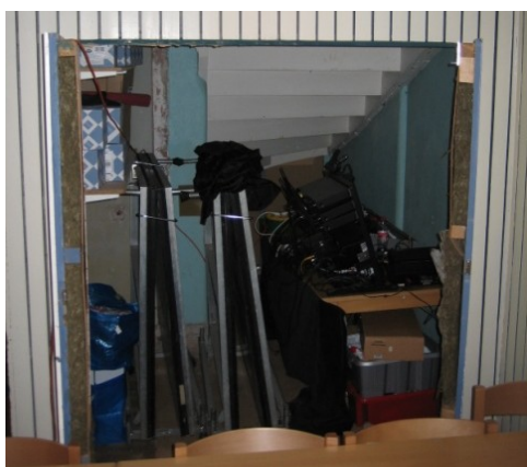
Figur 16: Det dolda förvaringsutrymmet under läktaren.
