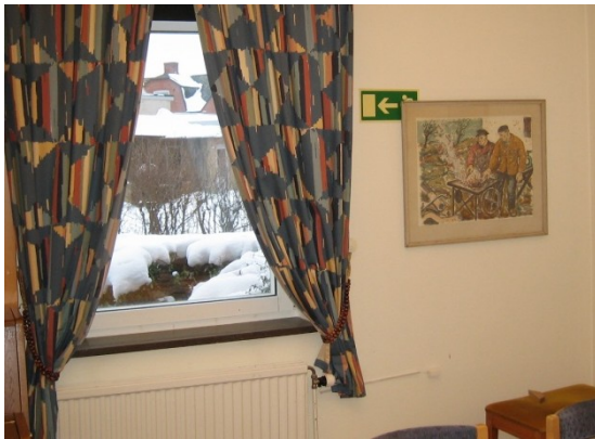
Figur 51: Felaktig placering av nödutrymningsskylt.
