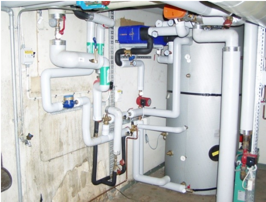
Figur 35: Värmepanna med tillhörande rördragning.
