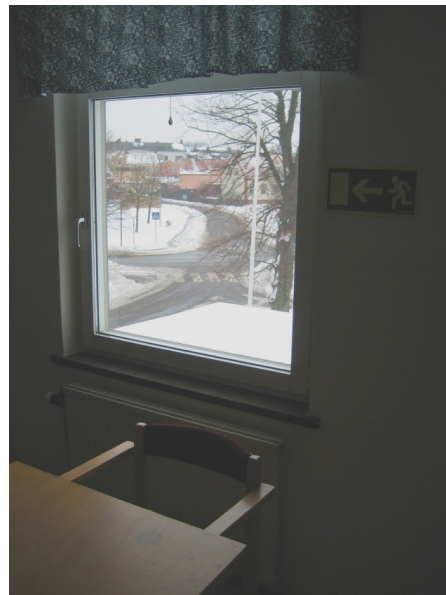
Figur 46: Utformning av den efterlysande utrymningsskylten som finns vid utrymningsväg som utgör fönster.
