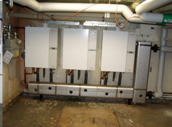
Figur 36: Apparatur i pannrummet till uppvärmningssystemet.
