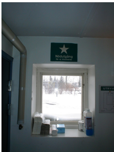
Figur 40: Utrymningsväg genom fönster vid logerna.
