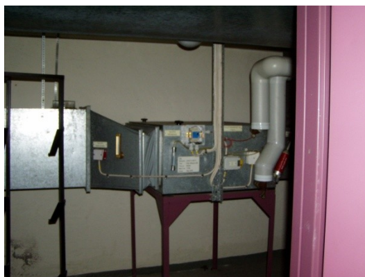
Figur 33: Ventilationsaggregat för ventilationssystemet i foajén och kaféet.
