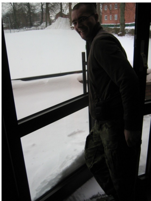
Figur 49: Nödutgång blockerad av snö.
