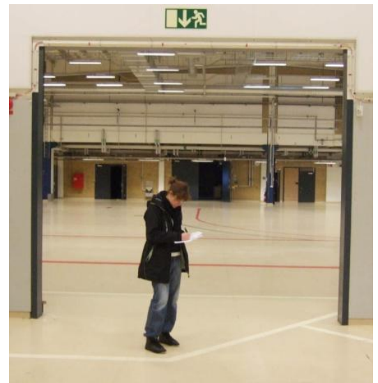
Figur 16. Vägledande markering i form av linjer i golvet och utrymningsskylt, foto privat.
