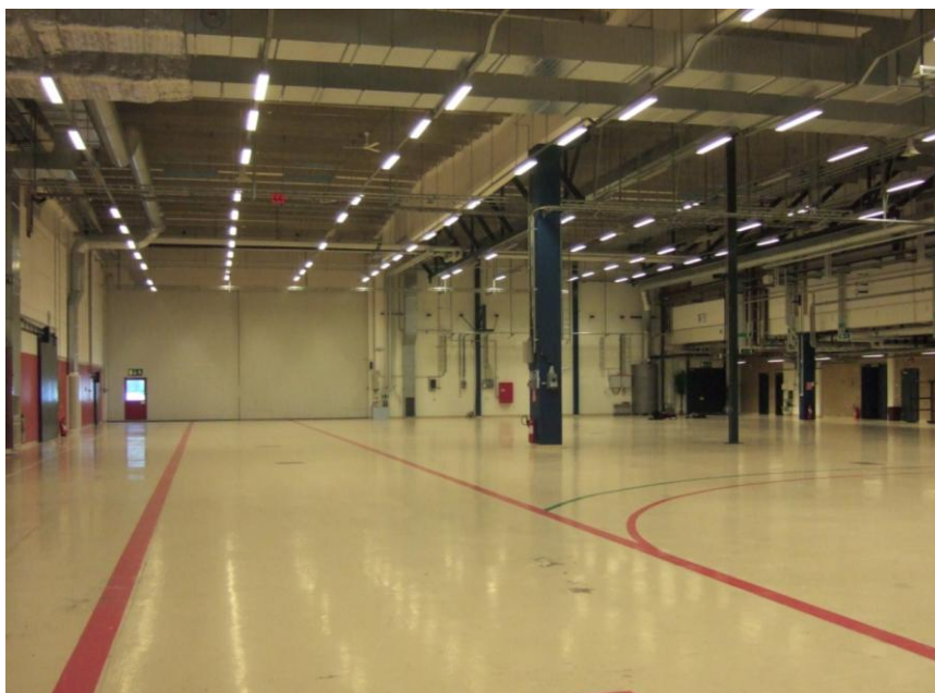
Figur 4. Fotografi över lokal A. Observera utgången med dörrbredd 1,0 meter till vänster i bild, samt överhäng till höger i bild, foto privat.
