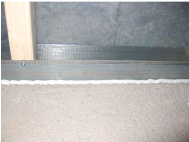
Figur 15 Plåtregel med plastfolie fogad mot betong (Wahlgren, 2010).
