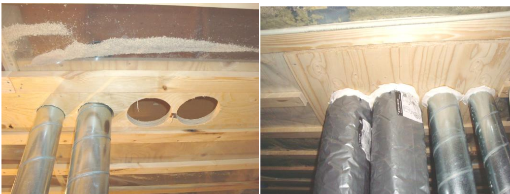
Figur 53 Genomföring av ventilationskanal med hjälp av träskivor samt fogning (Skanska Sverige).
