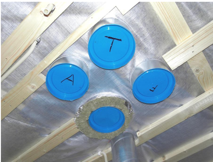
Figur 2 Ven0tilationsrör genom plastfolie i vindsbjälklag
