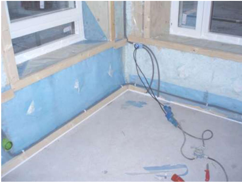
Figur 64 Hål för sprutning av lösull (Wahlgren, 2010)
