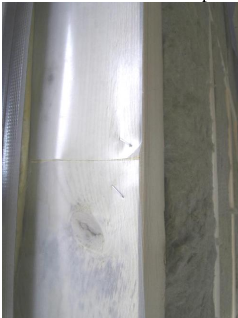
Figur 1 Ej överlappad skarv av plastfolie i fönstersmyg
