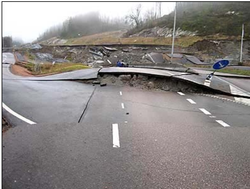
Figur 8. Skredet i Munkedal 2006. (Foto: SGI, 2006)
