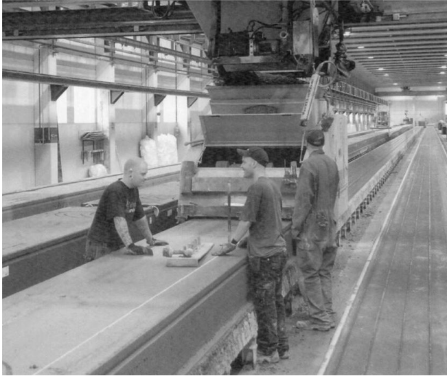
Figur 18. Gjutning av förspända håldäckselement.
