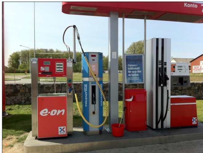
Figur 5 - Biogasstation på OKQ8 i Toftanäs.
