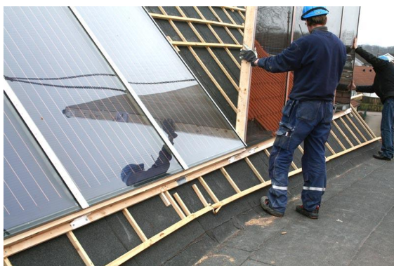
Bild 5.2 Takintegrerade solceller på Borgvalla Äldreboende. Fästs i bärläkten (ExoTech, 2011).
