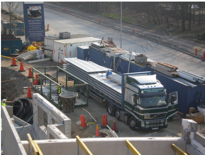
Figur 1.8 Plattbärlagen levereras till byggplatsen med lastbil (Vetra).
