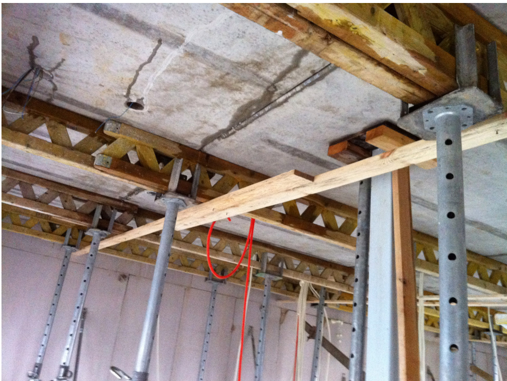
Figur 2.4 Stämning av plattbärlagen.
