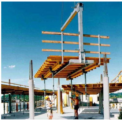
Figur 1.1 Ett formbord lyfts på plats med hjälp av kran och formgaffel (Betongbanken).
