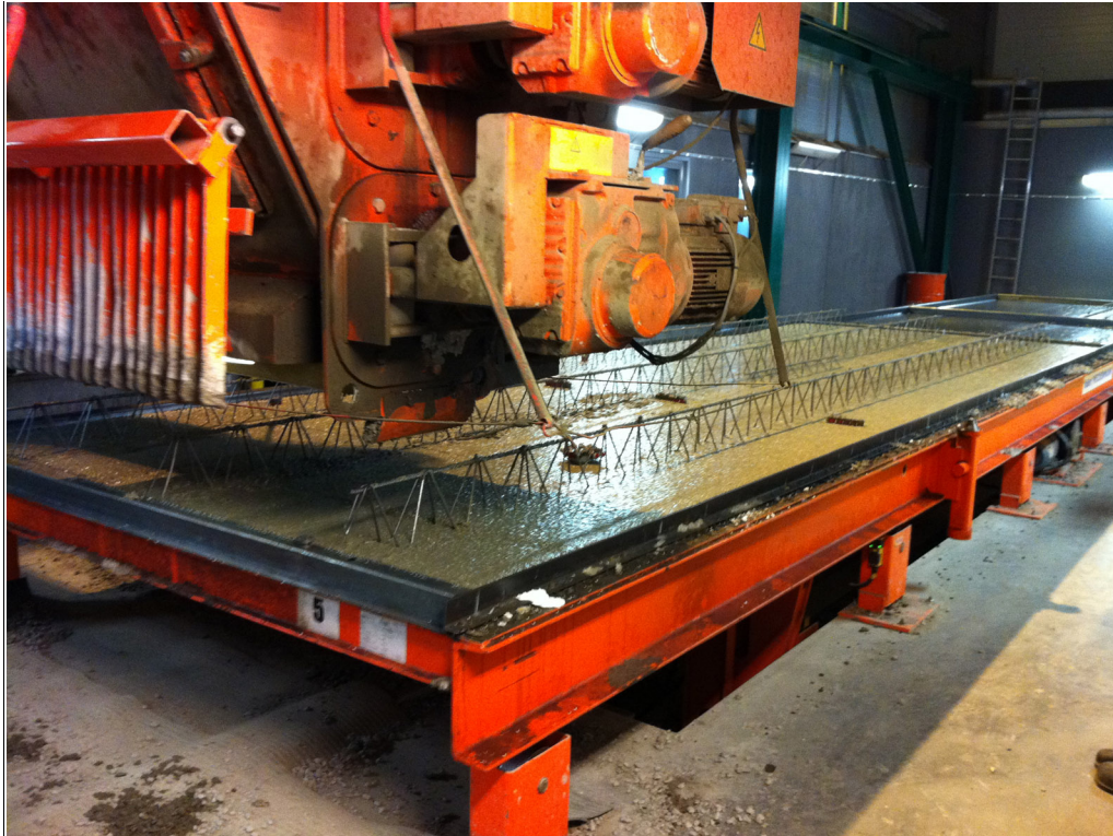
Figur 2.10 Plattbärlagen gjuts och ytan räfflas för att kunna samverka med pågjutningen.
