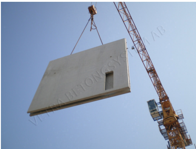
Figur 1.3 En skalvägg lyfts på plats (Vetra).
