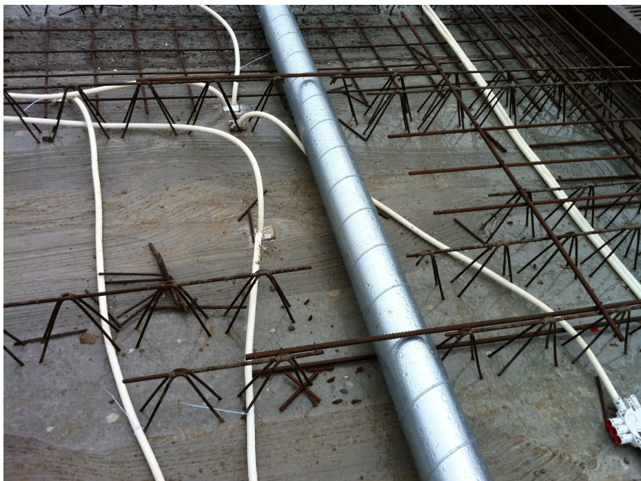
Figur 1.9 Armeringsstegarna har kapats för att ge utrymme åt ventilationsrören.
