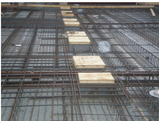
Figur 1.7 Ett armerat bjälklag med plattbärlag (Vetra).
