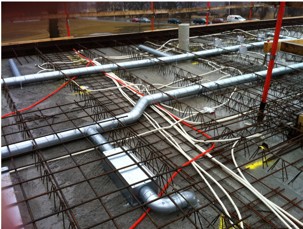
Figur 2.1 Plattbärlagen i Laröd strax innan pågjutning.
