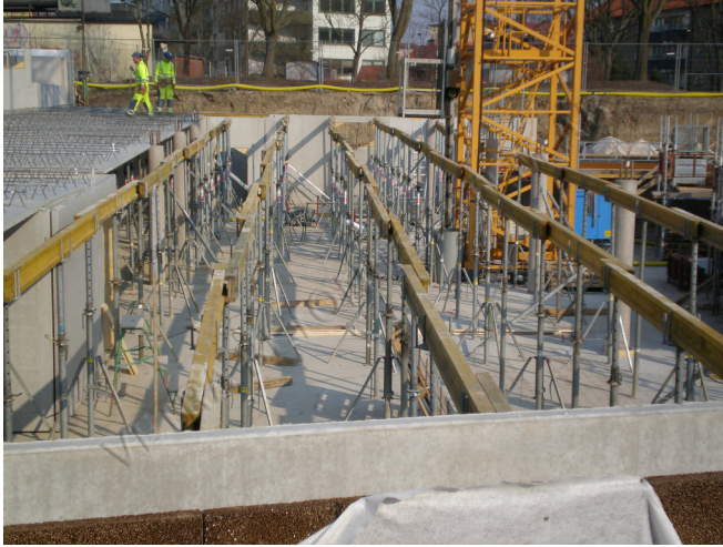
Figur 1.10 Stämningen med bockryggar är förberedd för leverans av plattbärlag (Vetra).
