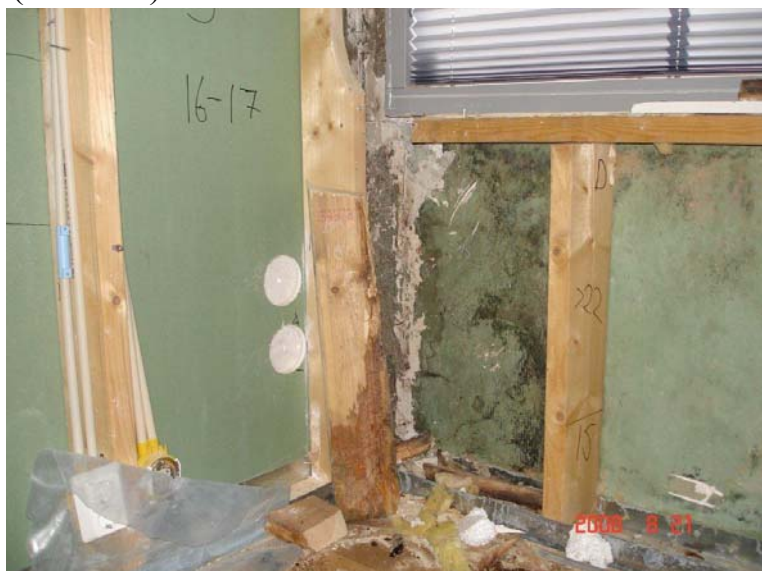
Figur 2.5. Trästimme som fått röta sett från insidan. Källa: Kenneth Sandin.
