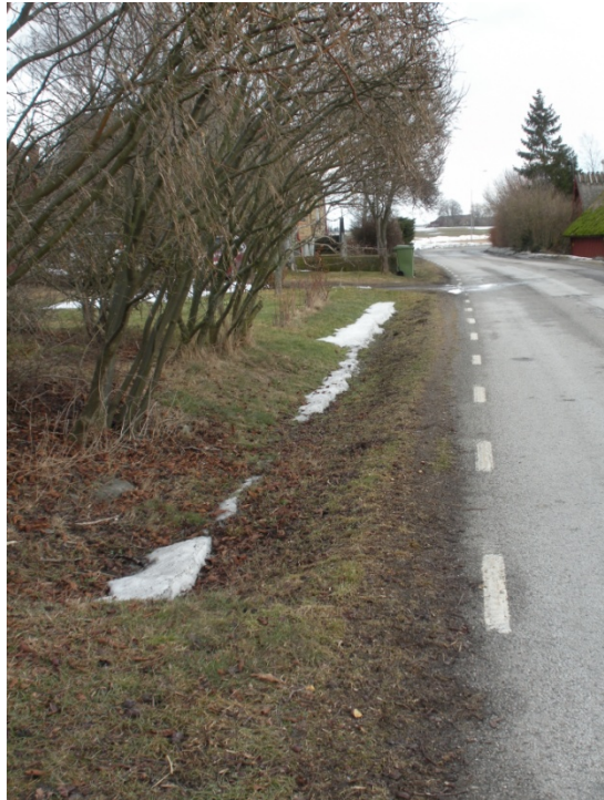
Figur 2: Ett torrt svackdike intill en väg och en gräsmatta. Fungerar även här som ett snölager vid vägplogning. Fotograf: Henrik Djerv 2010-03-18
