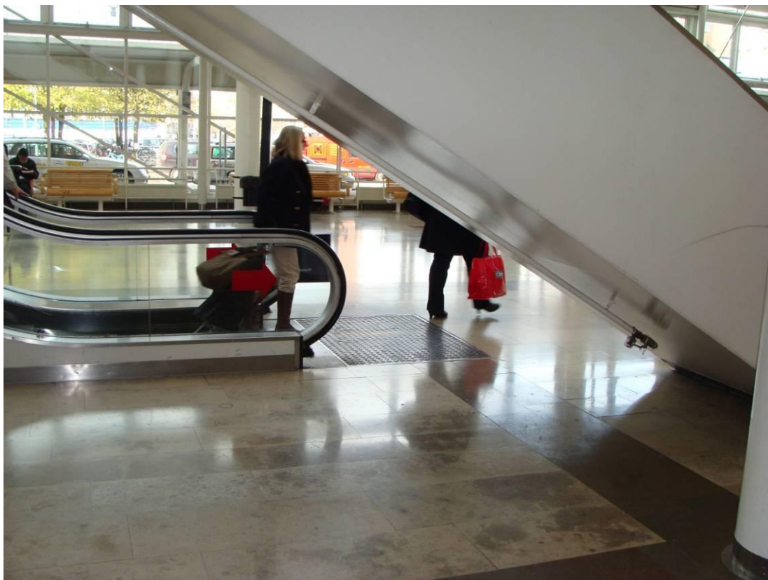
Figur 7: Bilden visar att skydd saknas vid trappa med reducerande höjd vid Helsingborgsstation. Foto: Nader Saber.
