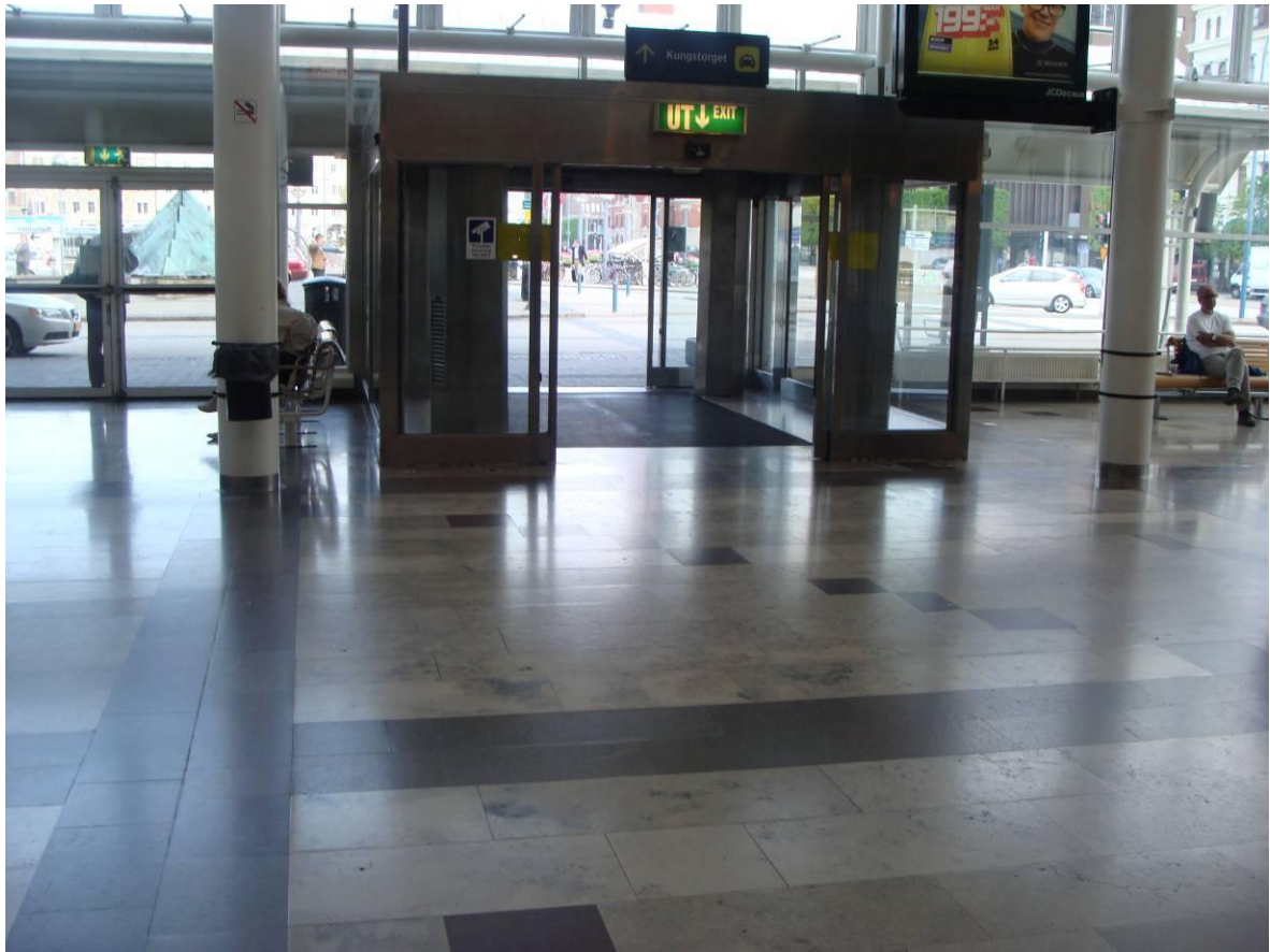
Figur 6: Bilden visar att taktila ledstråk saknas från norra parkeringen till plattformarna vid Helsingborgsstation. Foto: Nader Saber.
