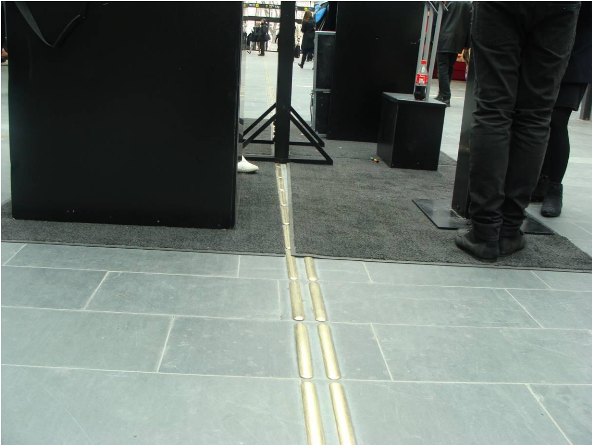
Figur 13: Bilden visar hur ett taktilt ledstråk ignoreras och blockeras av försäljare i Malmö Centralstation. Foto: Nader Saber.
