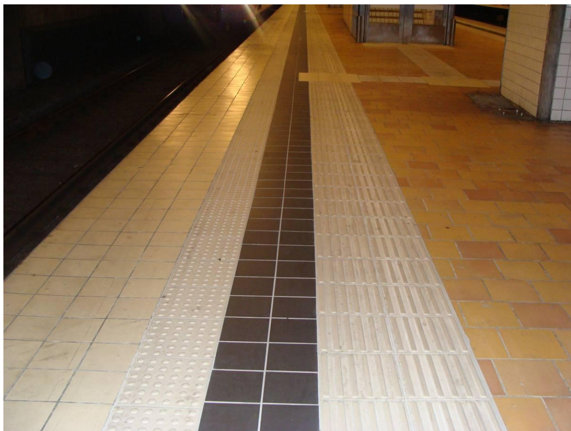
Figur 8: Bilden visar plattformskant och riskområde efter ombyggnation vid Helsingborgsstation. Foto: Nader Saber.
