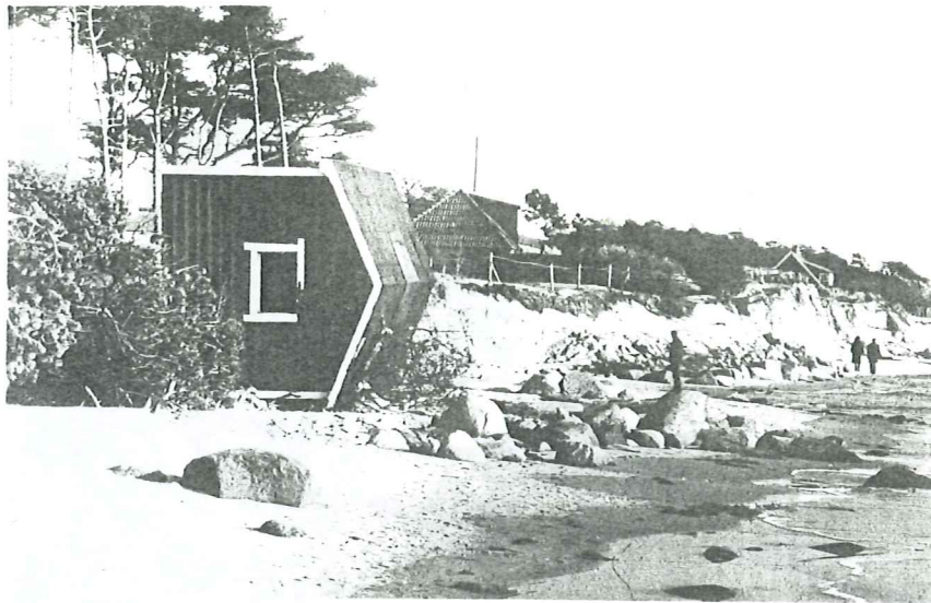
Fig. .2.4. Ett hus rasade ner på strandplanet under en storm årsskiftet 1974/75. (foto R. Åhman 1975).
