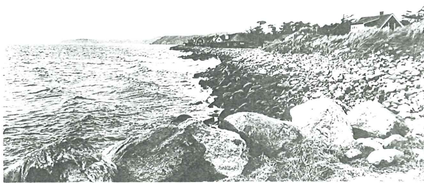
Fig. 5.1. Den västra delen av kusten är helt skyddad av stenskoningar (1-2, fig. 5.2.) (foto S. Osængius, 1992).
