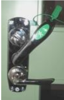
Figur 6.2 – Exempel på godkänt nödöppningsbeslag (Akademiska hus, 2011)
