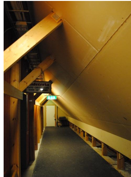
Figur 11.13 – Påbörjad gipsinklädnad av läktargången
