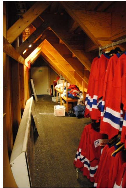
Figur 11.2 – Material som förvaras i läktargången.
