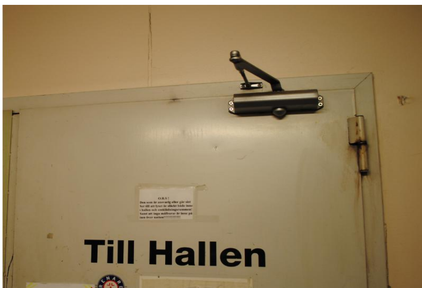
Figur 2.4 – Mekanisk dörrstängare.
