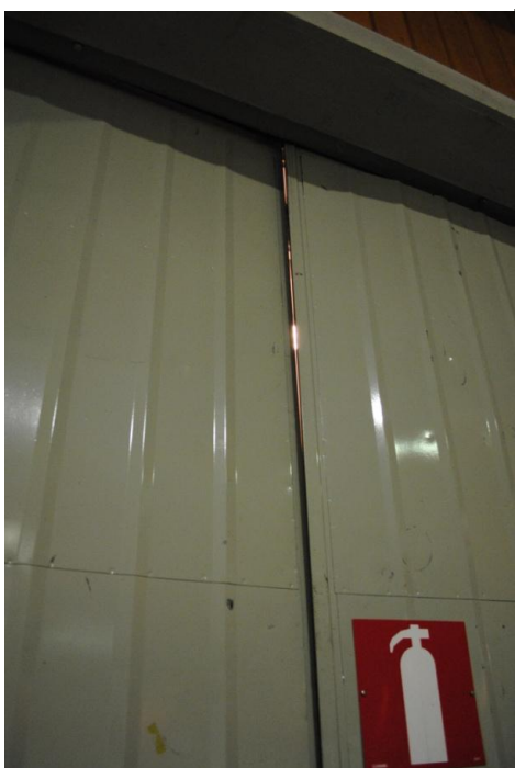
Figur 7.1 – Port mellan brandcell 3 och 4.
