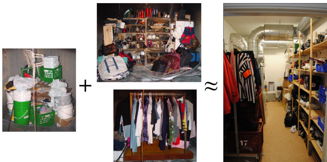
Figur 10.3 - Brännbart material i ventilationsutrymme, National Research Council till vänster, Bräcke till höger.
