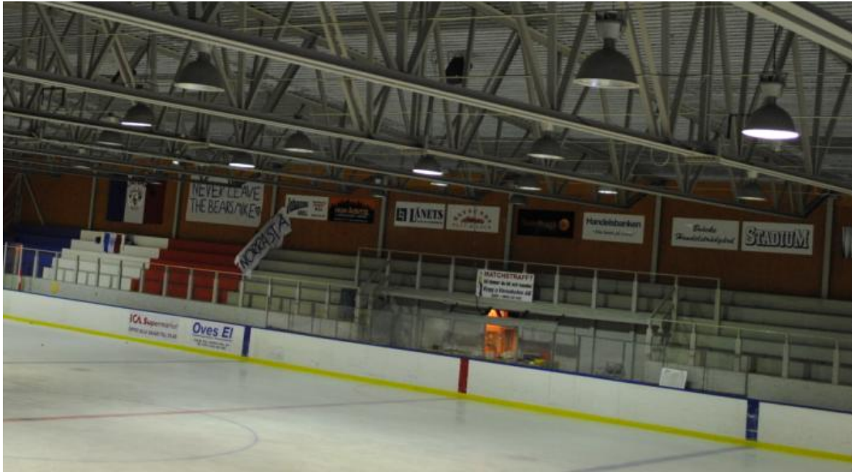
Figur 2.13 – Ishallens stålbärverk och innerväggar i obehandlat trä.
