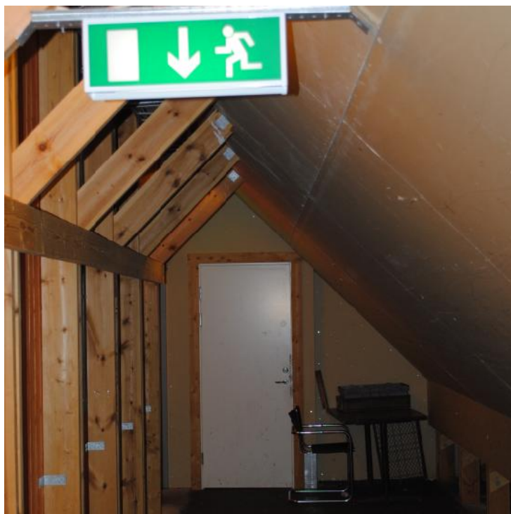
Figur 5.1 – Tändskyddande beklädnad i läktargång i form av gipsskivor.
