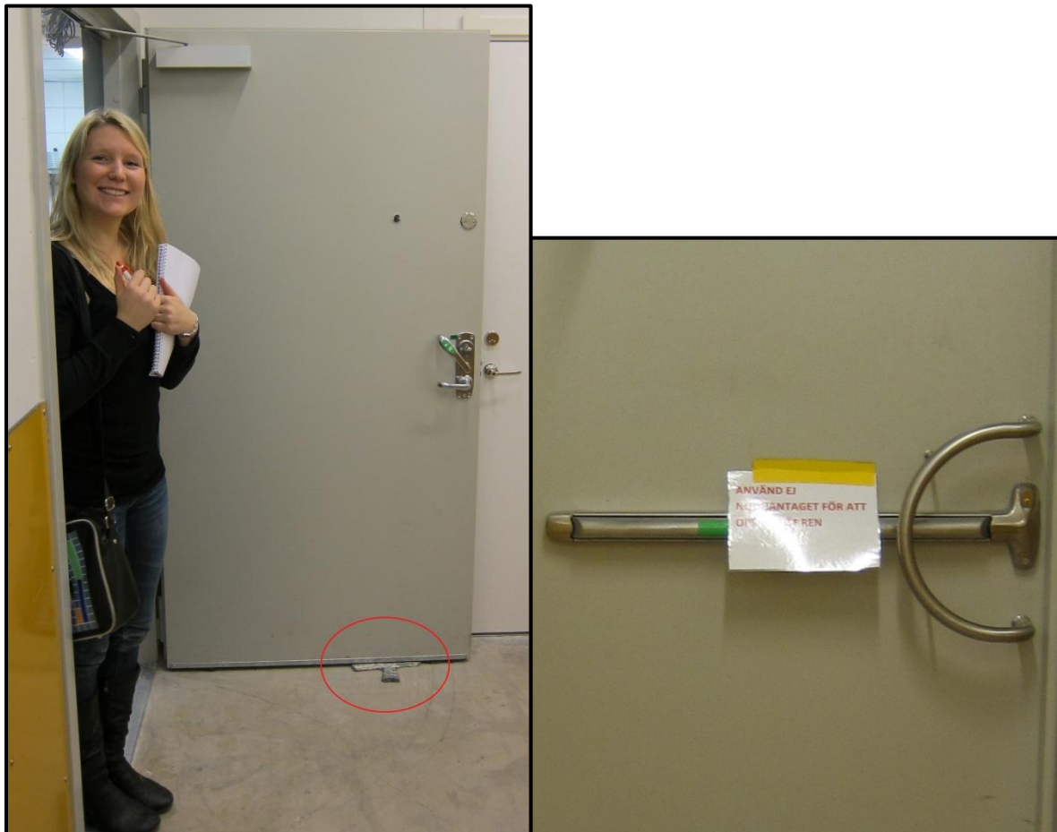
Figur 52. Exempel på missbruk av dörrar. Den vänstra delfiguren visar en dörr med klass EI-60 som är uppställd med en spackelspade. På lappen i den högra delfiguren står "Använd ej nödhandtaget för att öppna dörren".
