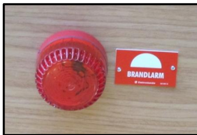
Figur 8. Blyxtlampa med rött sken som aktiverar vid utrymningslarm.
