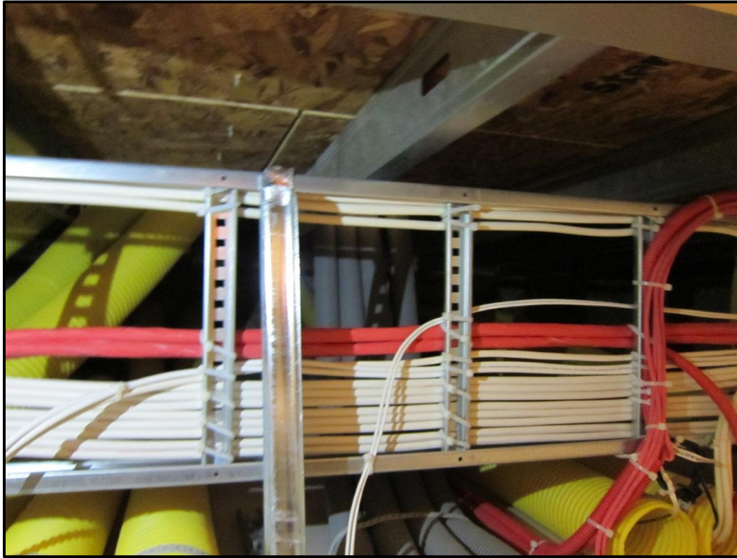
Figur 24. Elcentral i de bakre utrymningsvägarna.
