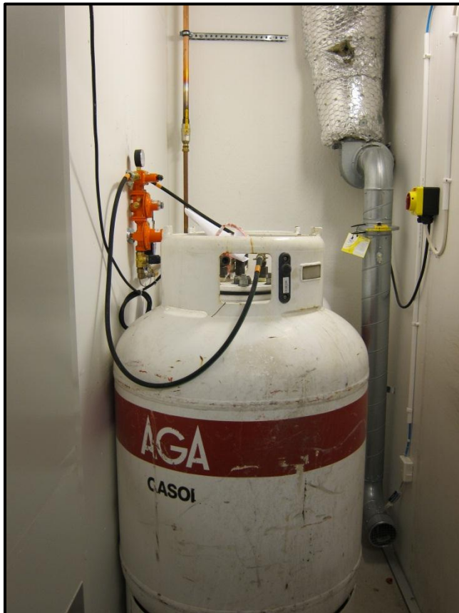
Figur 23. Gasbehållare inom avgränsning från omgivningen med klass EI120.
