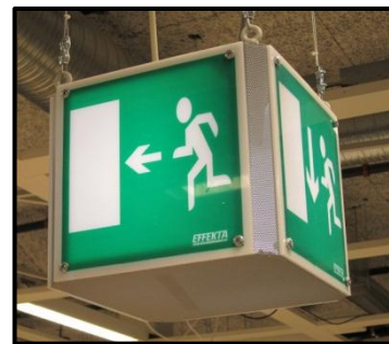
Figur 12. Nödutgångsskylt. Samtliga genomlysta skyltar kan drivas av reservbatterier om nätanslutningen slutar fungera.
